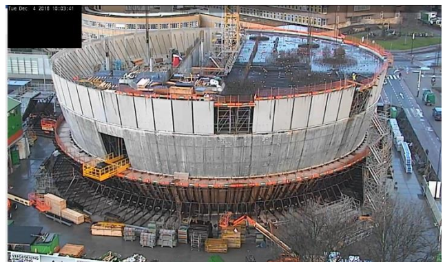
Prefab elementen tweede verdieping
