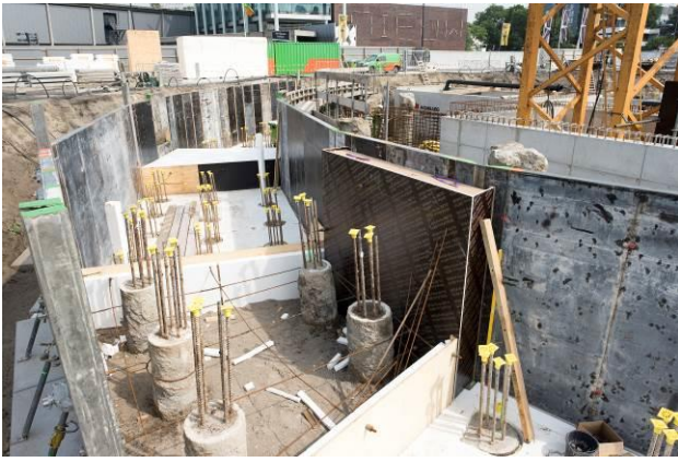
Gedeelte van de funderingsbekisting
