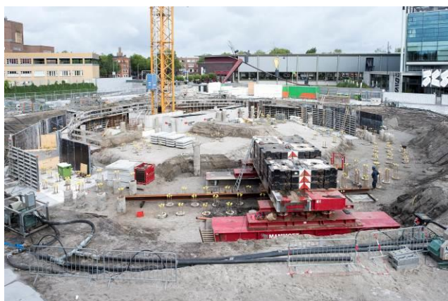
Testopstelling funderingspalen
